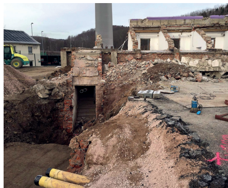
Januar 2016: Abriss des Tunnels im Rahmen des aktuellen Stadionneubaus. Foto: FCE/Ronny Graßer
